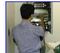
ビル設備点検
